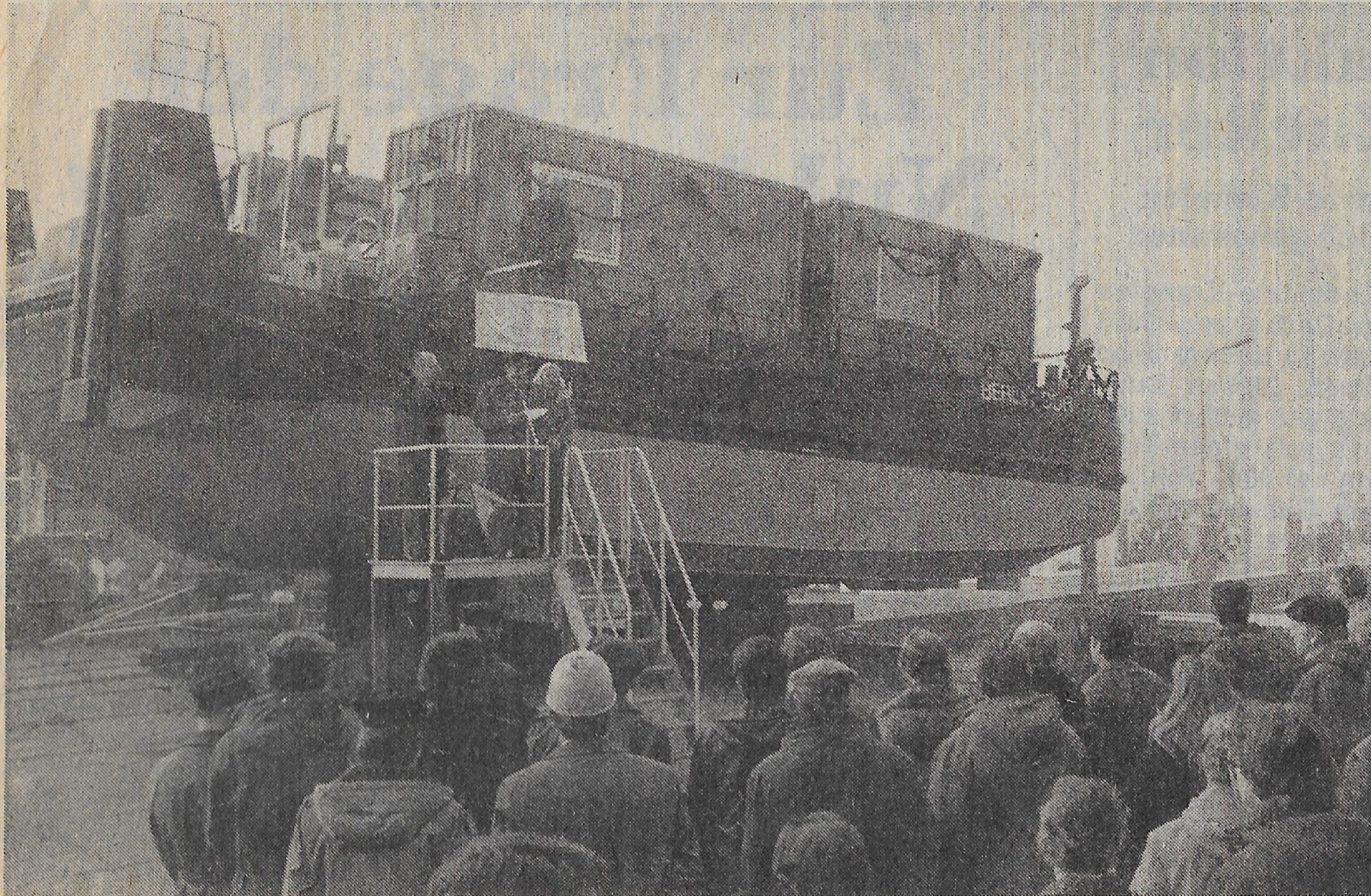
Kürzlich lief das neue Kanalschubschiff in der Yachtwerft Berlin vom Stapel. Mit seinem 220 Kilowatt starken Motor vermag es, einen Pramm mehr als bisher üblich zu schieben. Rechts: Blick in den Maschinenraum. Fotos: Kaufhold, ZB-Junge
